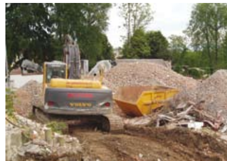
Abbruchmaterial muss unbedingt richtig entsorgt werden!
